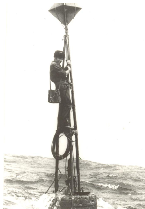
После шторма: починка отражателя
